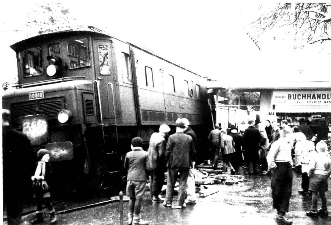
Die 1940 beim Stellwerk über die Schienen geratene Lokomotive.
