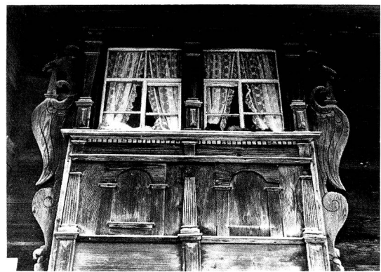
Seitenfenster am Haus Scherrer-Grob in der Furth. Abb. 7.
