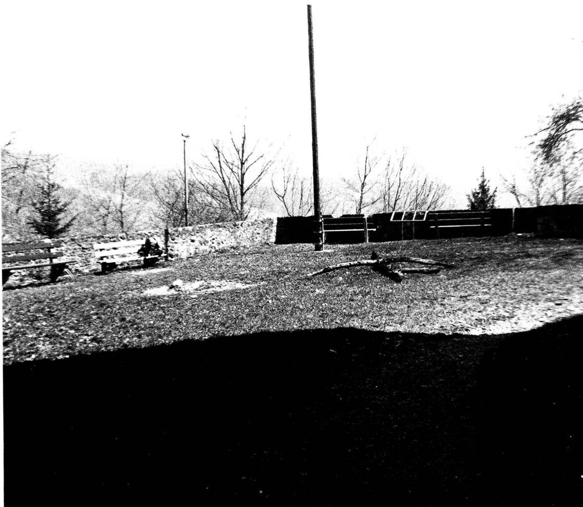
Burg Iberg: Blick in den Burghof mit der brusthoch wiederaufgebauten Umfassungsmauer.
