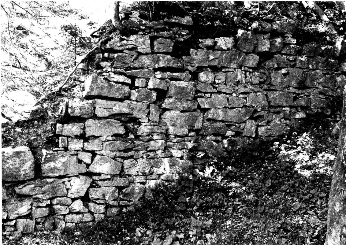
Wildenburg: Mauerwinkel im Westen der Anlage. Typische Mauerwerksstruktur bei Verwendung von Kalkstein: lagenhaft und kantig.
