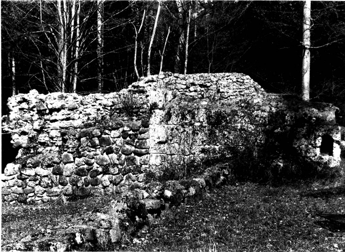
Rüdberg: im rechten Bildteil der massive Bergfried mit Tuffstein verkleideten Mauern. Im linken Bildteil die später an den Turm angesetzte Ringmauer aus Feldsteinen.
