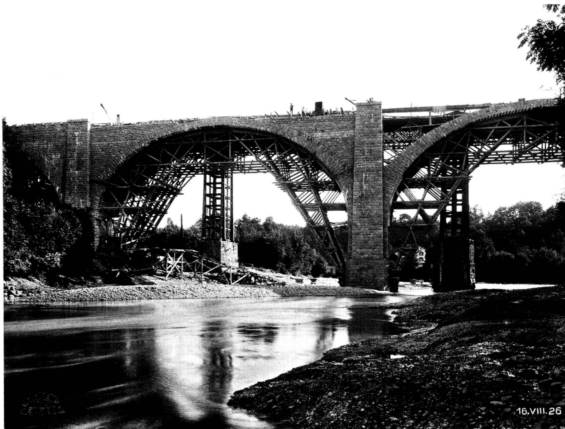
Abb. 12. Die doppelspurige, gemauerte Eisenbahnbrücke im Bau (1926).
