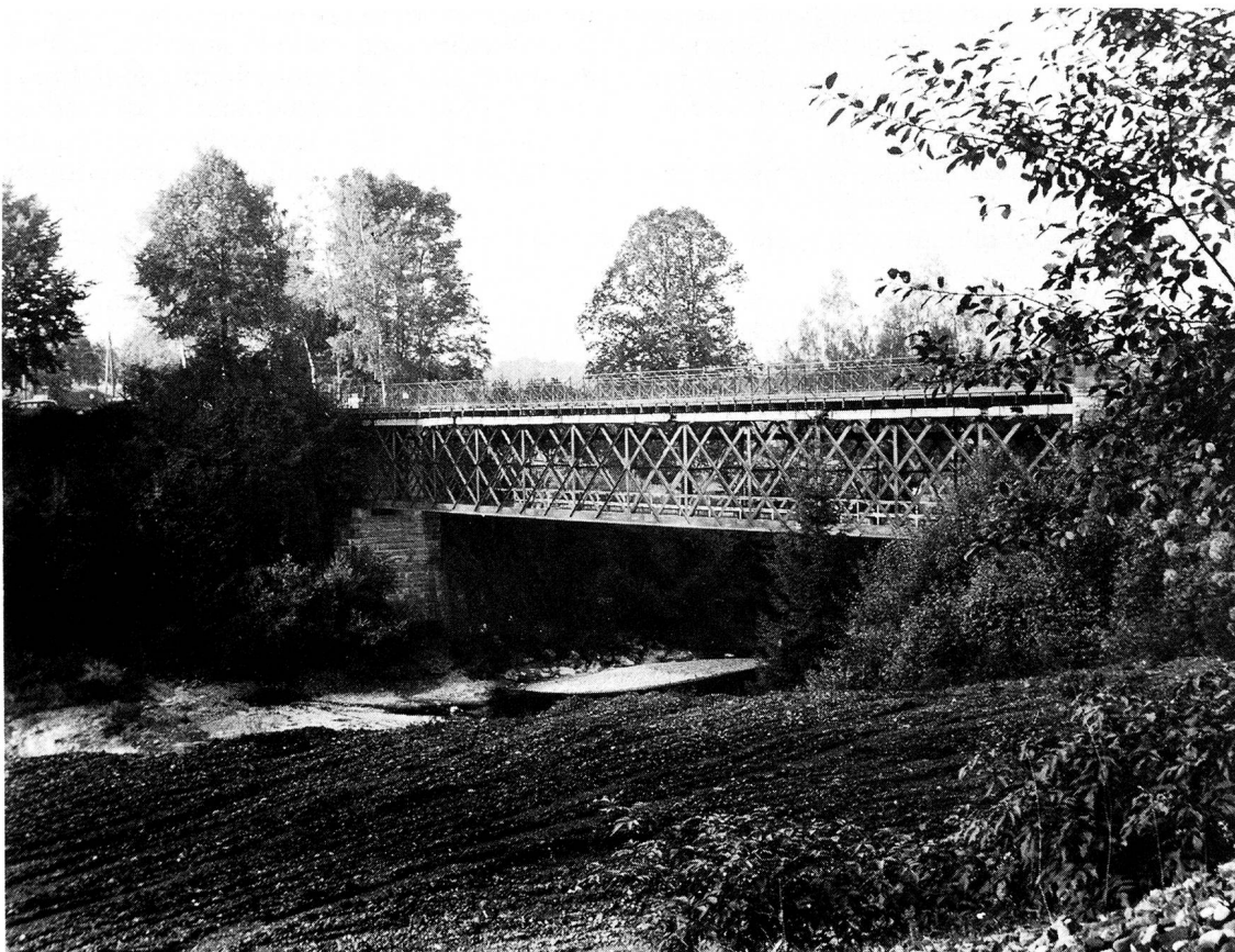
Abb. 6. Die Eisengitterbrücke von 1873. Im Vordergrund ein Teil der umfangreichen Aufschüttungen.
