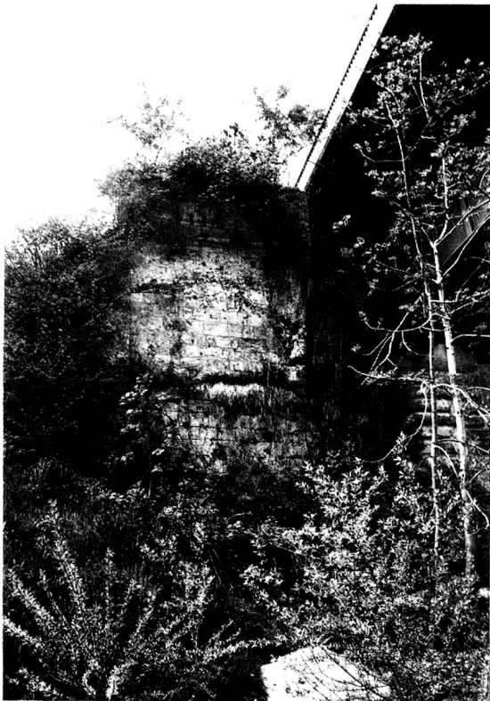
Abb. 9. Das heute noch sichtbare linke Widerlager der Holzbrücke aus Tuffstein. Darauf aufgesetzt die betonierte Verankerung für die Notbrücke.
