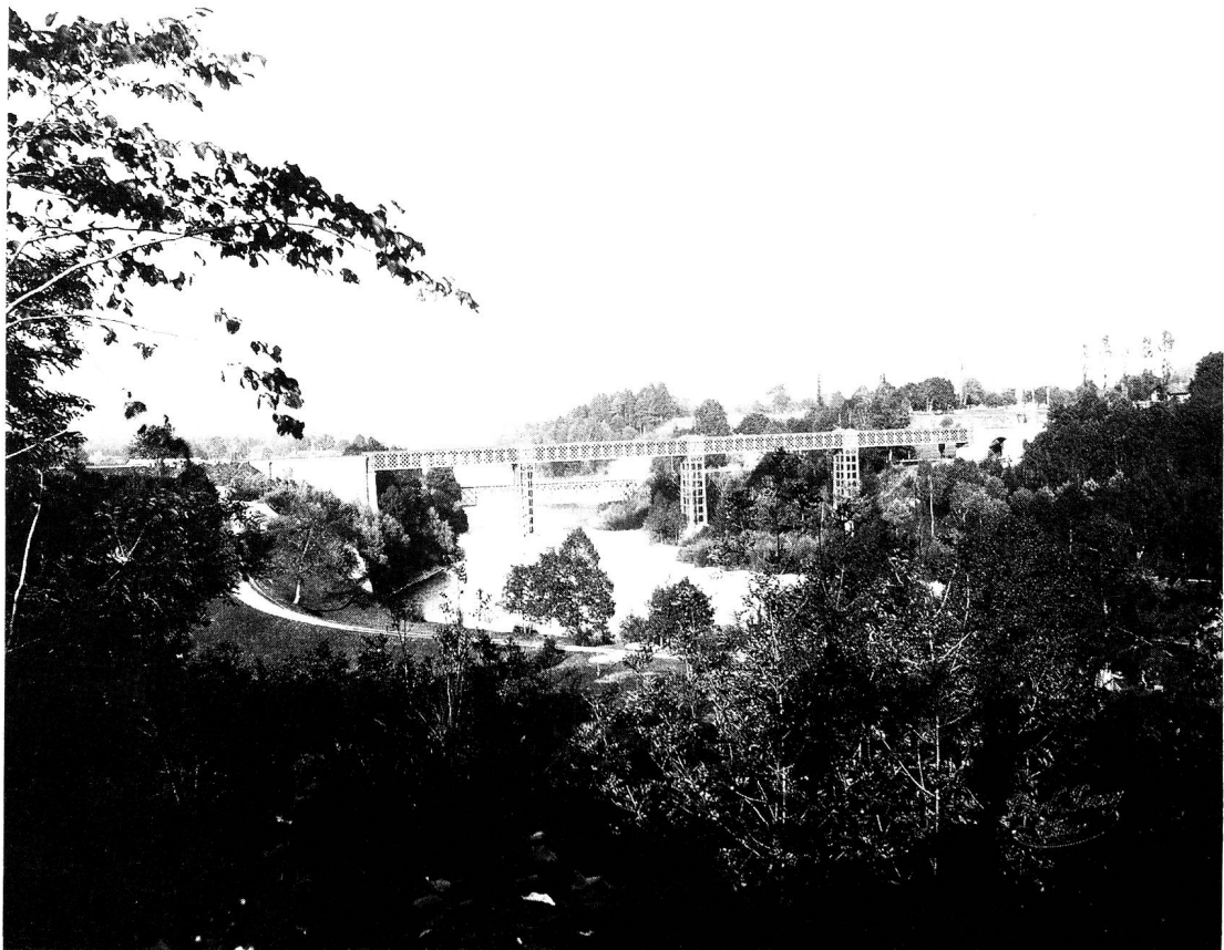
Abb. 11. Eisenbahn- und Strassenbrücke in Eisengitter-Bauweise.
