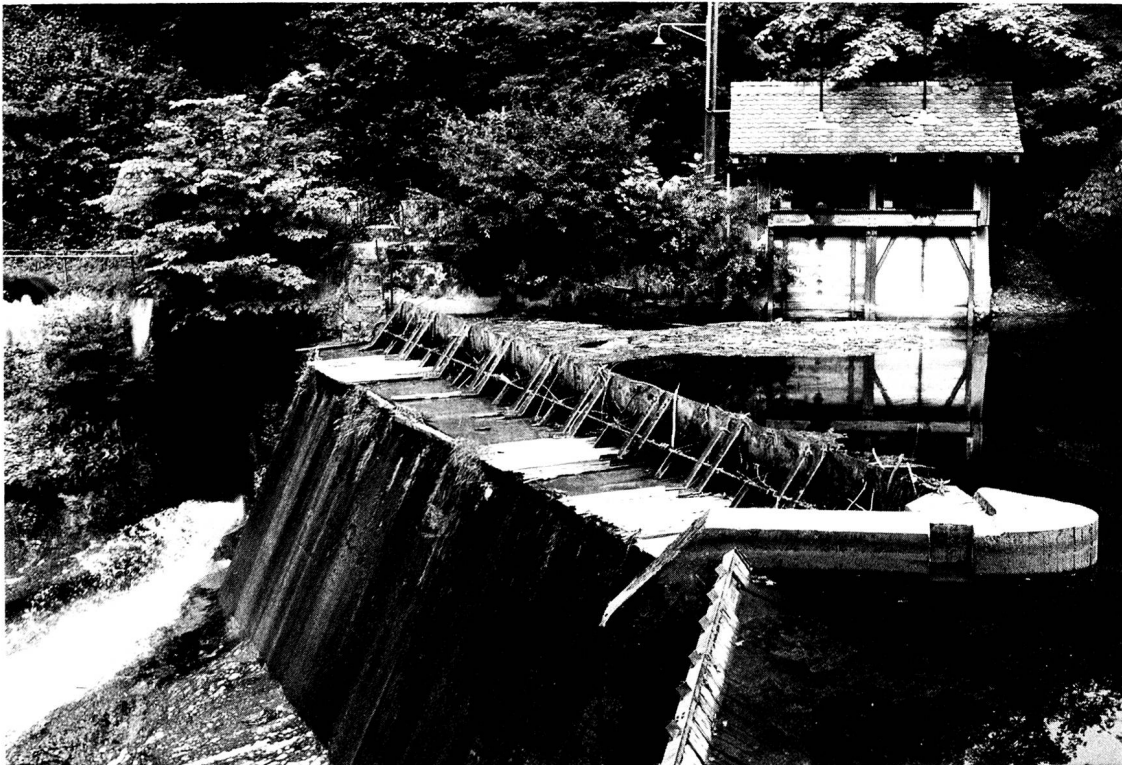
Verschiedene Textilbetriebe nutzen seit der letzten Jahrhundertmitte vorerst mit Wasserrädern, im 20. Jahrhundert mit Turbinen, in kleinerem Umfang die Wasserkraft der Thur. Die Abbildung zeigt die verborgene Wuhranlage für die Spinnerei Dietfurt.
