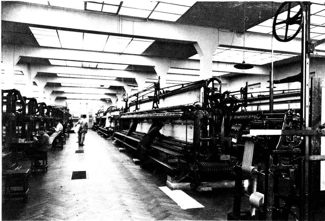
Degersheim. Schifflihall der Stickereifabrik Grauer-Frey. Moderne Flachdachkonstruktion mit Oblicht in Eisenbeton, 1906, von Curjel und Moser.
