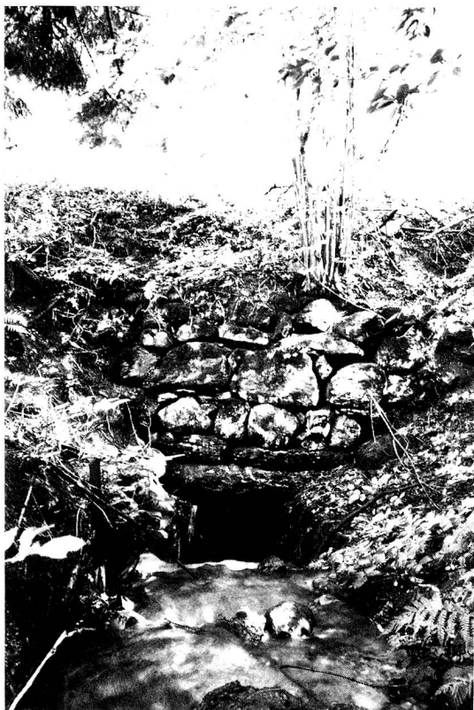
Aus der Postkutschenzeit stammt dieser Bachdurchlass unter der alten Rickenstrasse beim Gallenmösli. Den «Deckel» bilden hier aneinandergeriehene Sandsteinplatten.
