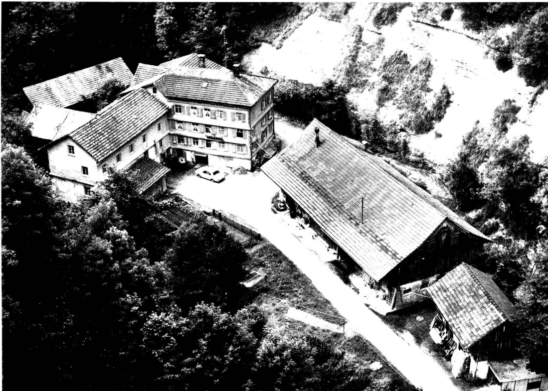
Die Gebäude der Guggenlochmühle in der Aufsicht von der SBB-Brücke von vorne nach hinten: Schopf, Stallscheune, Wohnhaus mit quergestelltem Betriebsgebäude, dahinter Kundensägerei.
