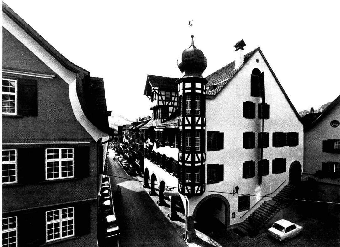
Das Rathaus mit Erkertürmchen und Giebellukarne in Fachwerk, rekonstruiert 1977/78 von Otto Stiefel, Wil, unter Leitung von Walter Fietz, St.Gallen. Ein Akt schöpferischer Denkmalpflege – aber welch beglückendes Resultat!
