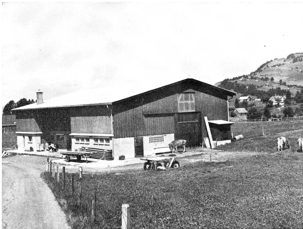
Moderne Oekonomiegebäude erlauben ein rationelles Arbeiten.
