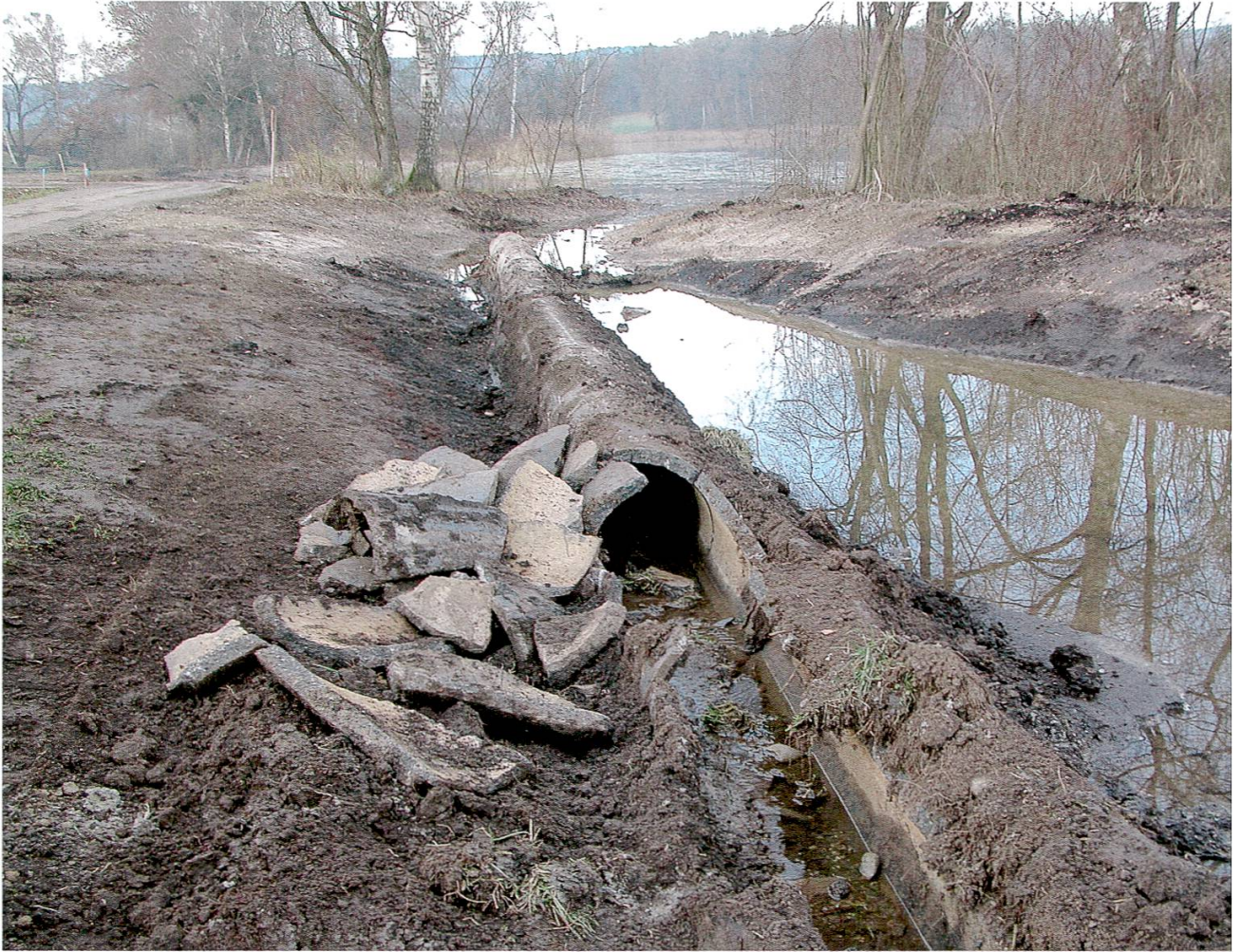
Abbildung 1: Bäche werden ausgedolt. (Foto: Joggi Rieder)
