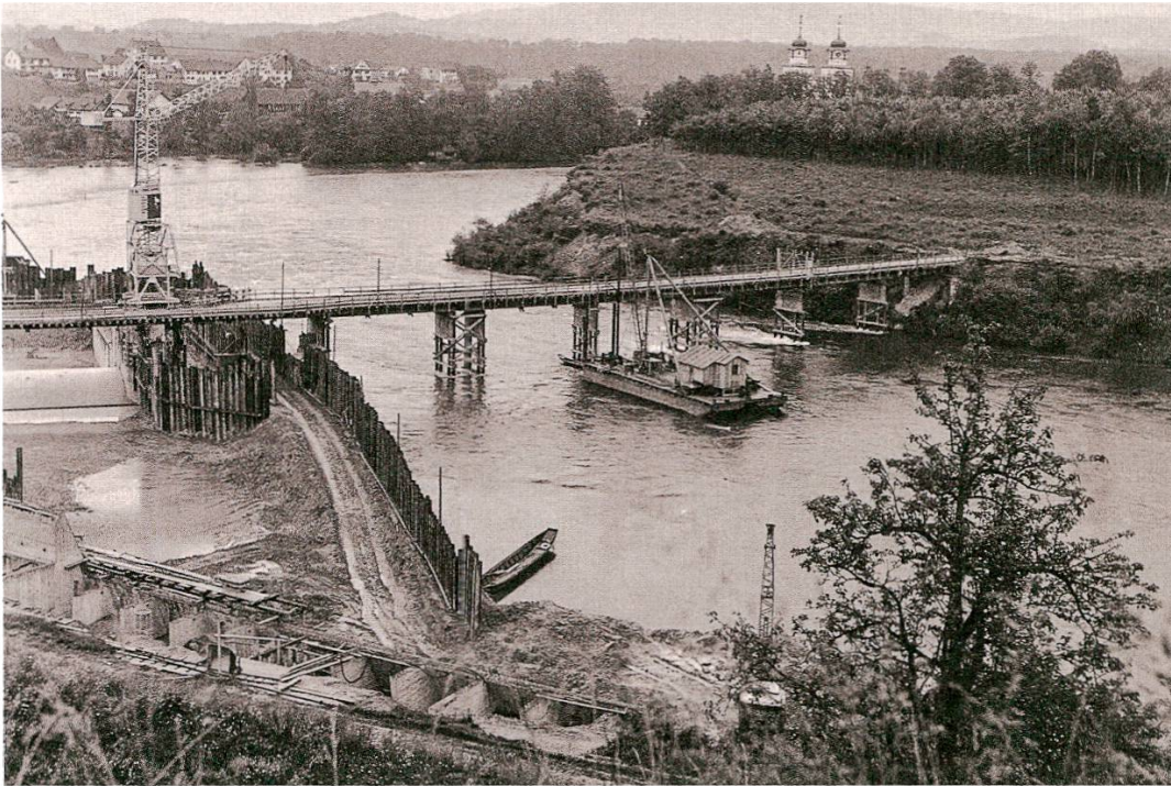
Trotz heftiger Proteste von Natur- und Heimatschutzvereinen begann 1952 der Bau des Stauwehrs für das Kraftwerk Rheinau oberhalb der Klosterinsel.
