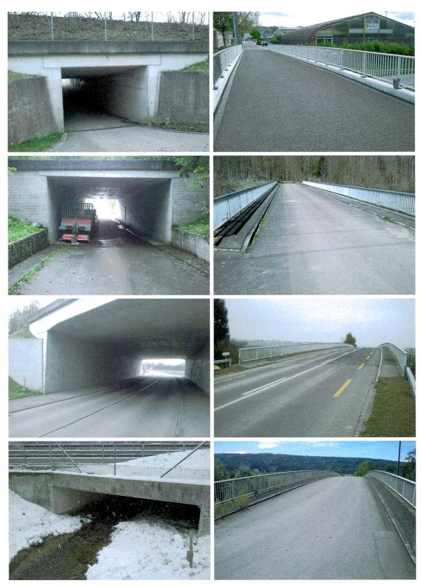
Abbildung 5: Beispiele verschiedener Bauwerkstypen, welche Wildtieren eine Querung der Autobahn A7 ermöglichen können. Die linke Spalte zeigt Unterführungen, inkl. eines Gewässerdurchlasses. In der rechten Spalte sind verschiedene Typen von Überführungen zu sehen.
