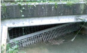
Abbildung 8: Die enge Röhre eines Gewässerdurchlasses wurde im Untersuchungszeitraum nicht von Wildtieren zur Querung der A7 benutzt (links). Die vorhandene Bibersperre eines Gewässerdurchlasses (rechts) verunmöglichte Wildtieren die Querung.
