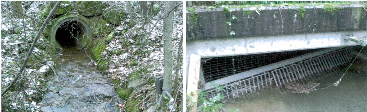
Abbildung 8: Die enge Röhre eines Gewässerdurchlasses wurde im Untersuchungszeitraum nicht von Wildtieren zur Querung der A7 benutzt (links). Die vorhandene Bibersperre eines Gewässerdurchlasses (rechts) verunmöglichte Wildtieren die Querung.
