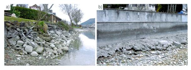
Abbildung 7: Entwicklung von Ufervorschüttungen und Ufermauern: Im ersten Schritt wird das Ufer mit Bauschutt o. ä. aufgefüllt (a) Stein am Rhein, Foto: 26.03.2011, später wird das Schüttungsmaterial mit Beton vergossen, sodass es als Fundament für die aufgehende Mauer dienen kann (b) Berlingen, Foto: 13.03.2011.
