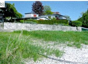
Abbildung 10: Beispiele für tief liegende Mauern (a) Fuss unterhalb der MWL, Allensbach, Foto: 28.04.2011 und für hoch liegende Mauern; (b) Fuss oberhalb der MWL; Allensbach, Foto: 20.04.2011. Die hoch liegenden Mauern lassen eine Vorlandvegetation zu und beeinträchtigen die Lebensräume des Eulitorals weniger stark als die tief liegenden Mauern.
