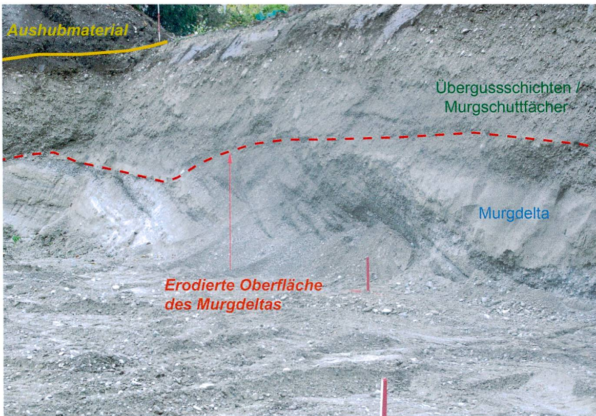
Abbildung 6: Baugrube in Frauenfeld (26. Oktober 2012) Bereich Kreuzung Laubgasse/Oberwiesenstrasse (Koordinaten: ca. 709'250/268'350): Murgschuttfächer über Murgdelta mit erodierter Grenzfläche. Blickrichtung Nordnordost nach Südsüdwest.
