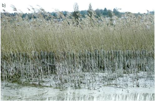
Abbildung 15: (a) Wellenbrecher (Schwimmkampen und Palisaden) im Schilfgebiet vor Triboltingen mit Beobachtungsplattform (Nov. 1985); (b) ehemalige Schilfschutz-Palisaden vor Triboltingen (10.03.2011, beide Fotos: W. Ostendorp).
