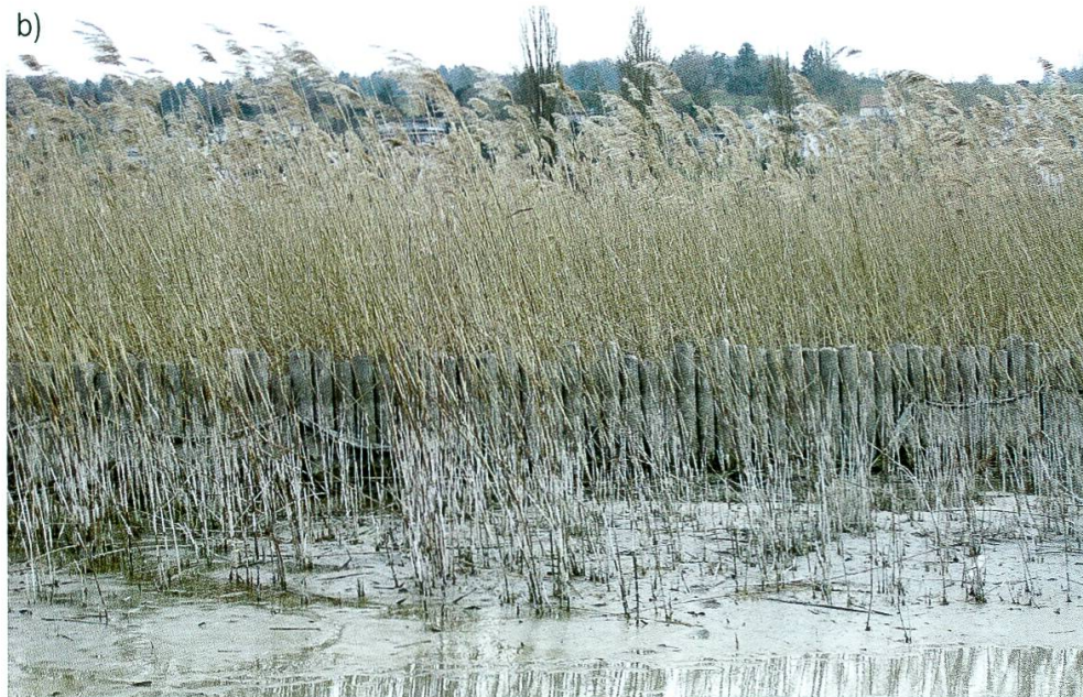
Abbildung 15: (a) Wellenbrecher (Schwimmkampen und Palisaden) im Schilfgebiet vor Triboltingen mit Beobachtungsplattform (Nov. 1985); (b) ehemalige Schilfschutz-Palisaden vor Triboltingen (10.03.2011, beide Fotos: W. Ostendorf).
