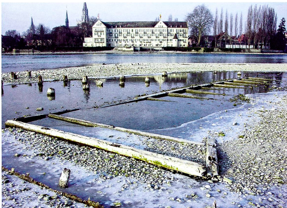
Abbildung 1: Bei Niedrigwasser sind noch die Reste von Stauzeilen und Holzkonstruktionen der ehemaligen Rheinmühle im Konstanzer Trichter zu erkennen (29.01.2006/Foto: Michael Dienst).
