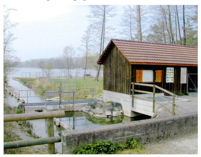
Abbildung 5: Die Tiefenwasserableitung am Hüttwilersee.
