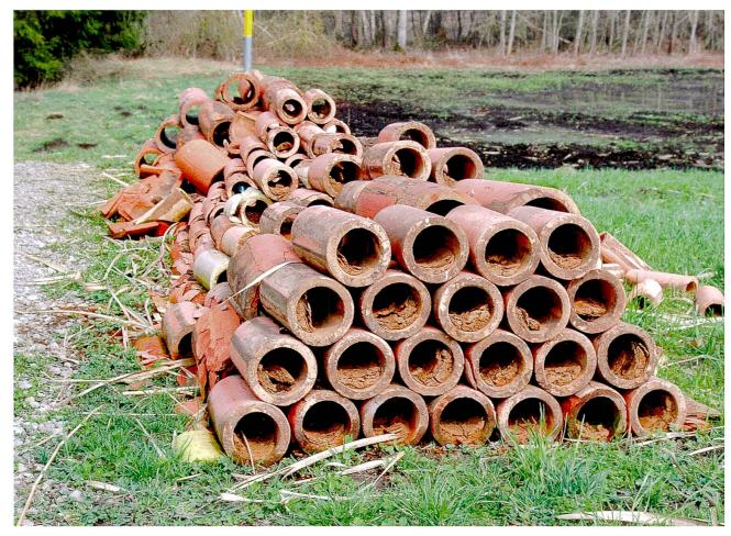
Abbildung 1: Ausgegrabene Drainagerröhren. (Foto: Joggi Rieder)
