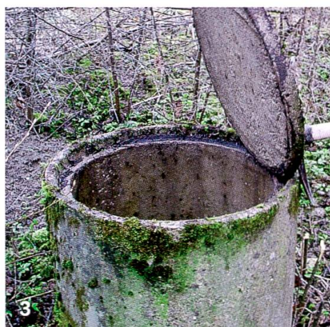
Abbildung 3: Grundwasser-Messrohre in Schächten: 1: Kleiner Schacht, nach längerer Suche im Wald ausgegraben. 2: Mittelter Schacht, ebenerdig, von Gras überwachsen und frisch ausgegraben. 3: Überstehender Schacht mit grossem Durchmesser.
