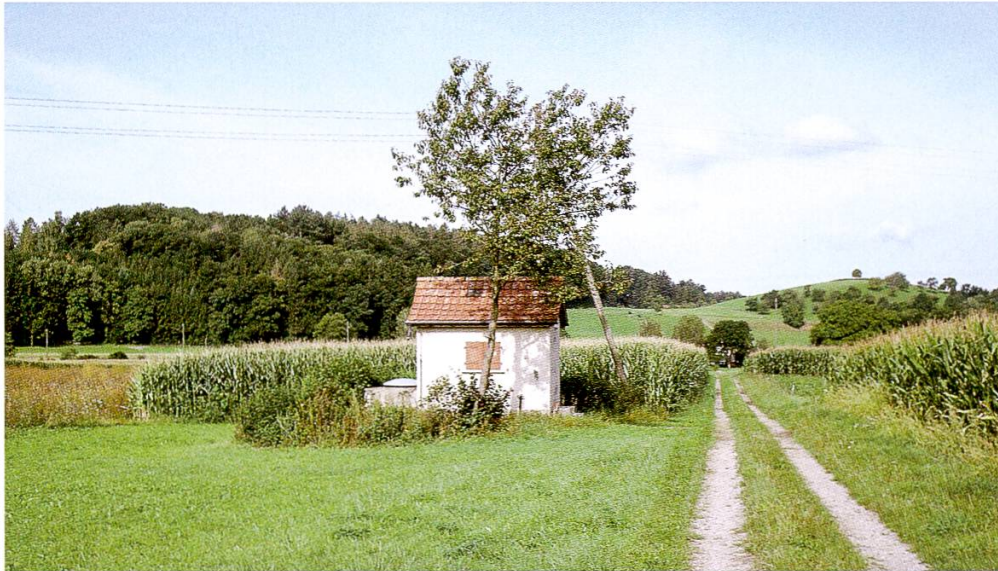
Abbildung 3: Grundwasserfassung mit Pumpenhaus und Fassungsschacht.
