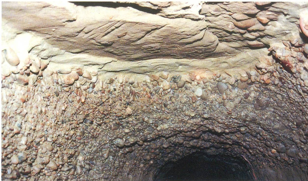
Abbildung 11: Fassungsstollen Schocherswil: Ein Schotterkörper von innen!
