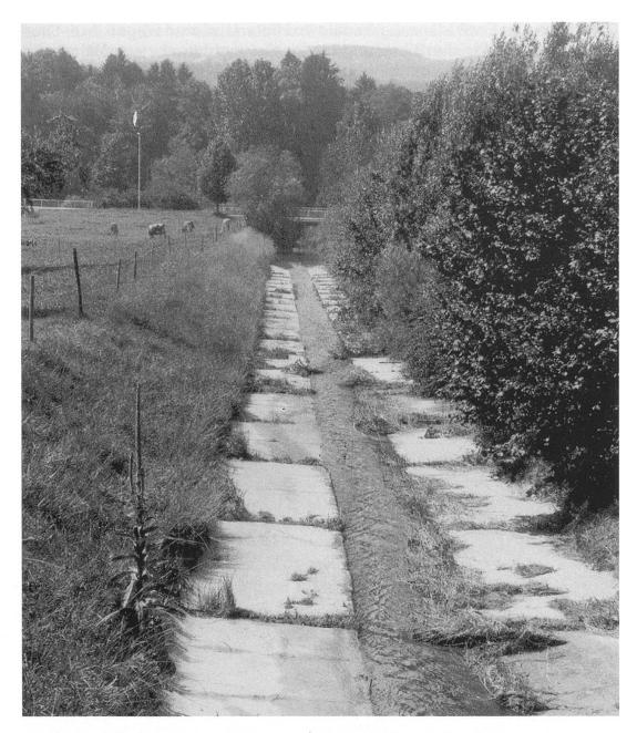
Abbildung 5: Ungeeigneter Biotop. Tobelbach südlich Müllheim mit seitlichen Betonplatten.
