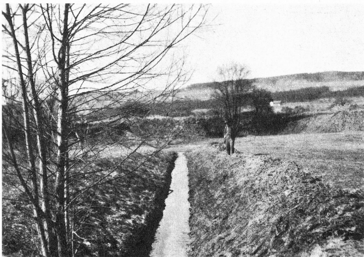
Versickerung von Oberflächen-Drainagewasser ins Grundwasser in einer Kiesgrube nordöstlich Bürglen. März 1952
