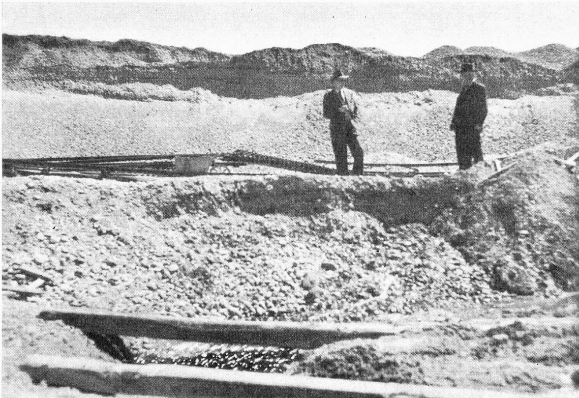
2—4 m mächtige Schotterschicht des Schaarenwaldes auf einer von der Ziegelei Paradies bis 20 m tief erbohrten Lehmmasse lagernd. Unter den beiden Holzbalken starker Grundwasserausfluß sichtbar
