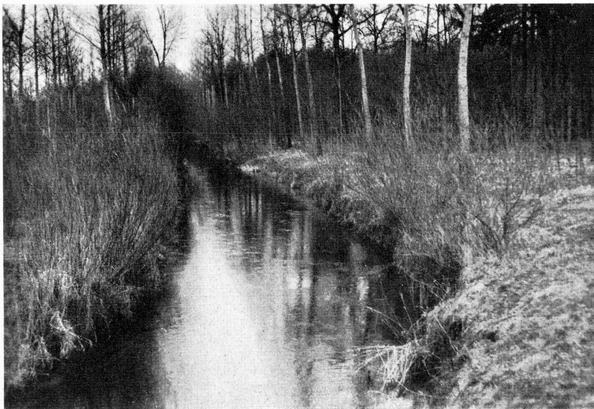
Binnenkanal Pfysterbrücke-Rohr, bei Rohr im Juli 1949 3 200 Sekundenliter Grundwasser führend
