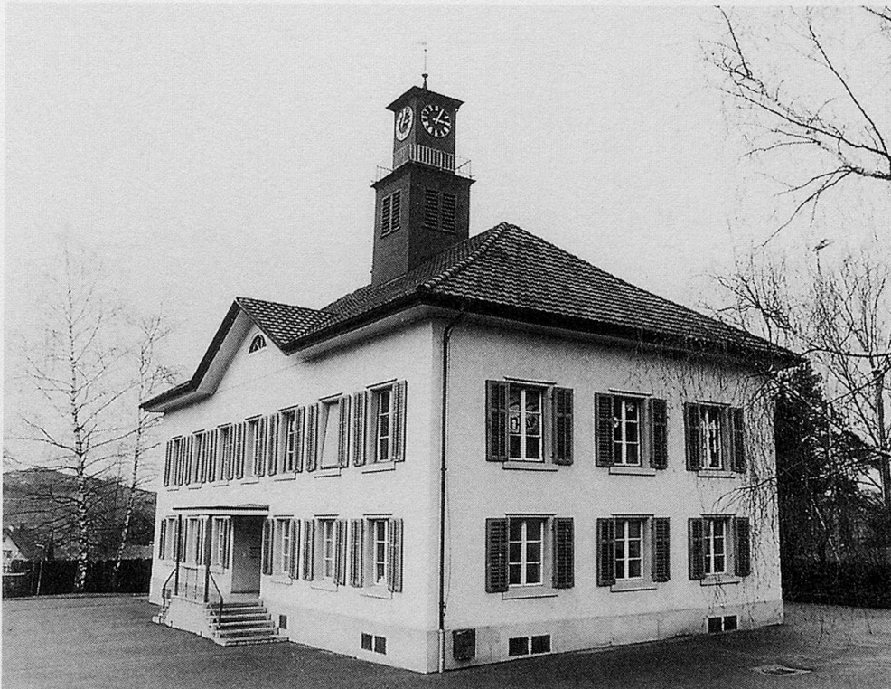
Schulhaus Mettlen, erbaut um 1850 nach Vor- bild des Schulhauses Mühlebach. Foto von 1989 (Denkmalpflege).
