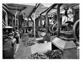
Die Zerkleinerung der natürlichen Rohstoffe; vorn Steinbrechmaschinen, ganz hinten die Rüttelsiebe mit den Säcken zum Auffangen des gesiebten Korns
