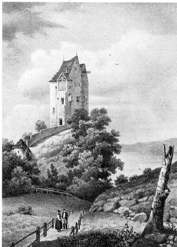
Schloß Salenstein nach dem Abbruch des Südteils (1828)
