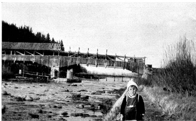
Der Abbruch hat begonnen
