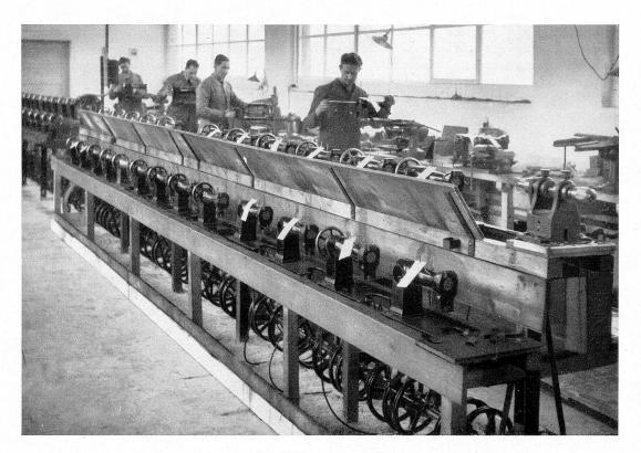
Montage des Oberteiles der Nähmaschinen
