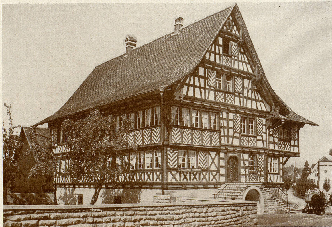
Wohlfahrts Haus der Firma Löw A. G. Oberaach - Das Haus gilt als der schönste Riegelbau der Schweiz
