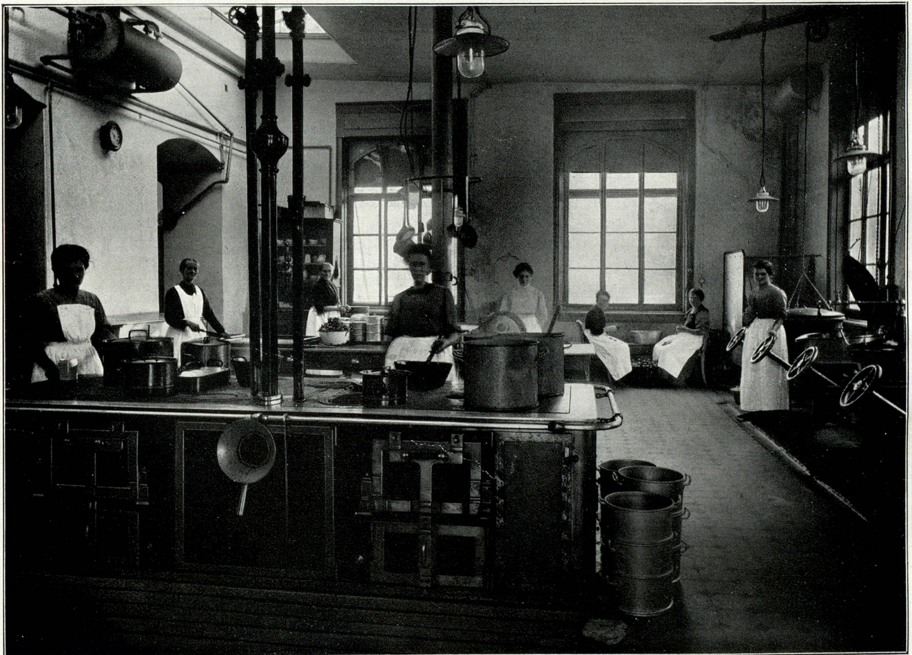
Die Küche im Kantonsspital Münsterlingen
