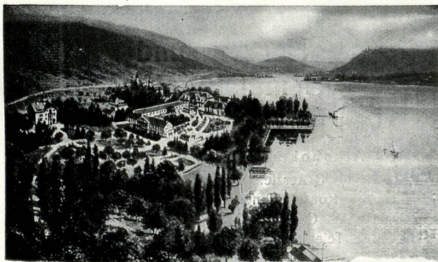
Gesamtansicht der Kuranstalt Mammern
