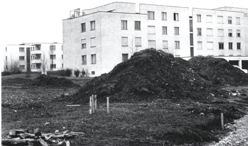
Abb. 2: Die Siedlung wurde auf freiem Feld errichtet und schloss an einen bestehenden Wohnkomplex an. Im Gelände lagerte der Aushub, der später für die Bodenmodellierung der Umgebungsgestaltung verwendet werden sollte. Foto: 1972.
