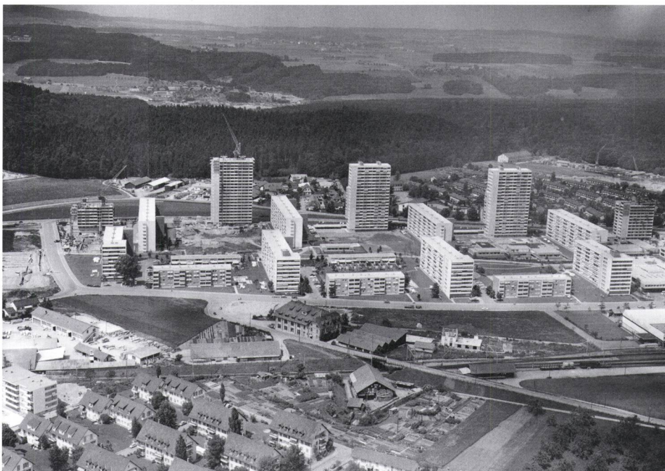
Abb. 1: Die Hochhaus-siedlung Bern Bethlehem in Muri bei Bern 1964. Bäurische Versatzstücke und neue Baustrukturen.
