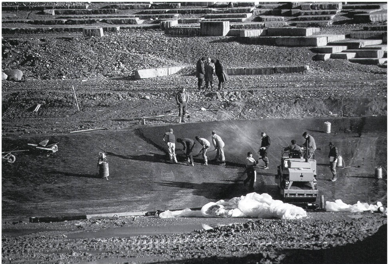
Abb. 7: Der Bau des Allmendesees im Park der Universität Irchel, 1986.
