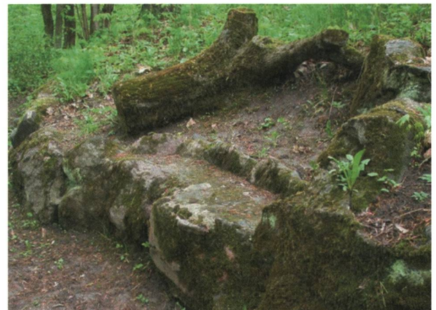
Fig. 7: Les faux éléments végétaux en béton sous les mousses dans le parc de Lentvaris.
