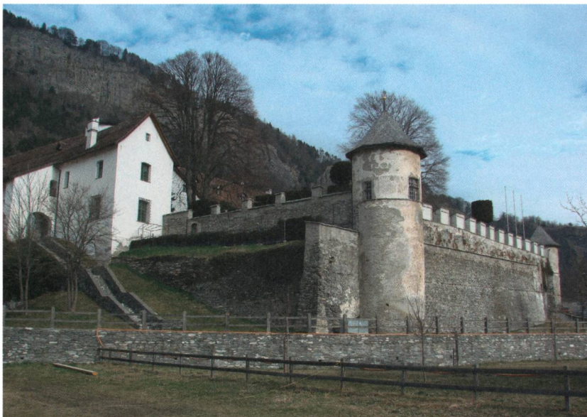
Abb. 1: Das Terrassenbauwerk des Schlossgartens Haldenstein von Südwesten.
