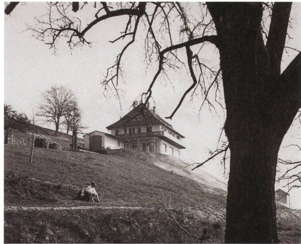
Abb. 2: Auf der grünen Wiese: Das Haus im Winter 1936/37 nach seiner Fertigstellung.
