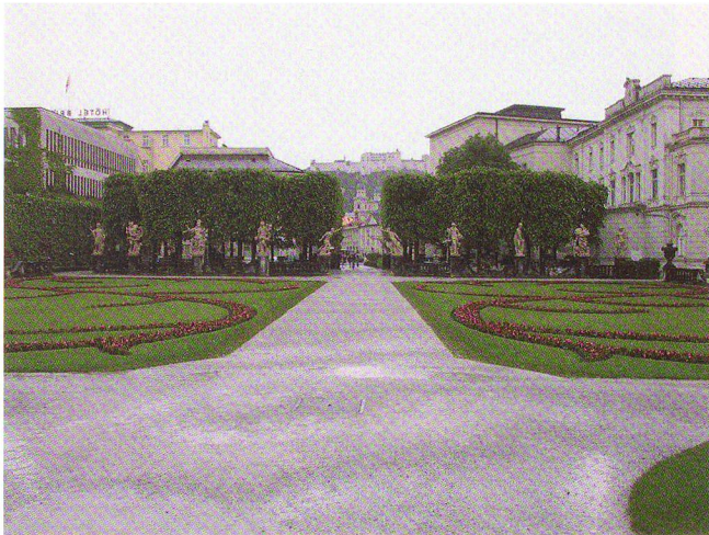
Abb. 6: Mirabellgarten mit Blick Richtung Altstadt und Festung von Salzburg – aufgrund der intensiven Nutzung als wichtiges touristisches Ziel müssen die Wege in kurzen Abständen mit neuen Schichten ergänzt werden. Intensiver Tritt, vielschichtige Aufbauten und starke Verdichtung haben Wellenbildung und Regenpfützen zur Folge (links). Ebenso erfuhr das viel genutzte Grosse Parterre in Schönbrunn zahlreiche Überdeckungen mit unterschiedlichsten Materialien, darunter auch Bauschutt und Lehm (s. Grabungsprofil, rechts).
