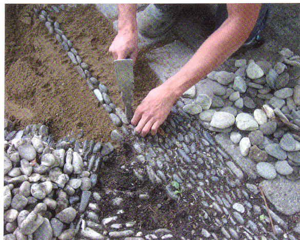
Abb. 10: Pflasterer bei der Arbeit.
