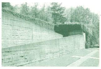
Abb. 10: Friedhof Horw, Stützmauern und Rampen aus schalungsrohem Sichtbeton; Willi Neukom, 1962–64, 1971, 1981/1982 (Etappen) (Aufnahme von Barbara Holzer, 2005)
