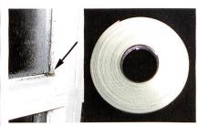
Abb. 3: Bei bober Temperaturdifferenz schwitzen Fassadenfenster, was häufig zu Schimmelbildung führt (Pfeil links). Das neue textile Fensterband löst dieses Problem (rechts).
