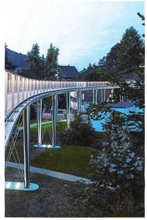
Abb. 1: Die längste Textilbetonbrücke der Welt
