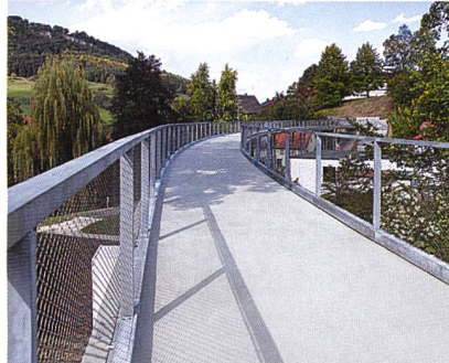
Abb. 4: Kein zusätzlicher Belag
