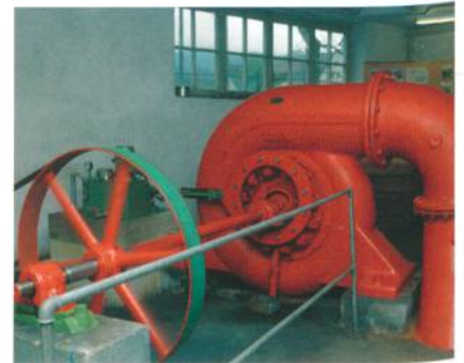
Abb. 2: Die Turbine aus dem Jahre 1862 wird vom Wasser der Luterer angetrieben und produziert heute jährlich rund 80'000 Kilowattstunden elektrische Energie
