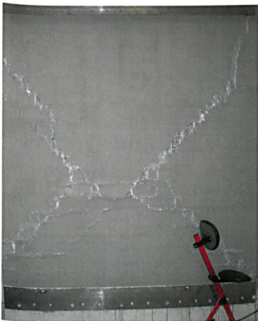
Mauersegment nach dem Erdbeben-Test
