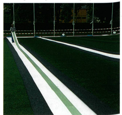
Vorbereitung zur Verbindung der Bahnen
