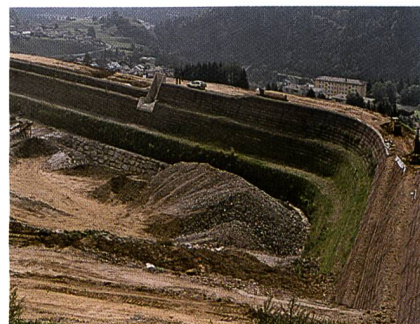
Abb. 2: Der neue Schutzdamm im Bau
