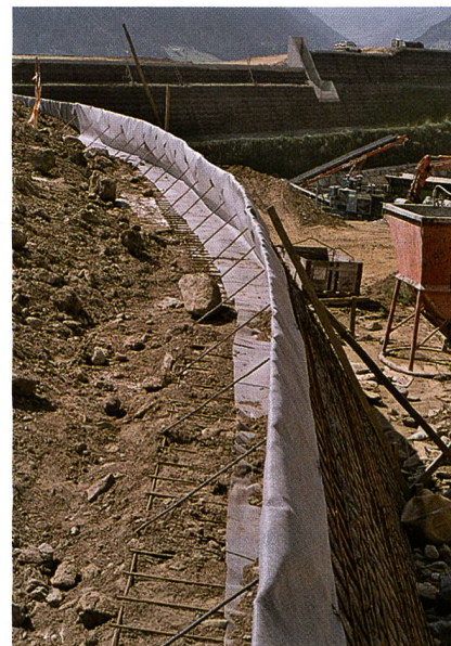
Abb. 3: Bepflanzbares System aus Vliesstoff für Steilböschungen
