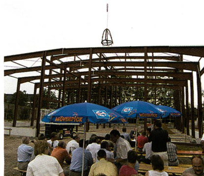
Aufrichtung der neuen Anlage
