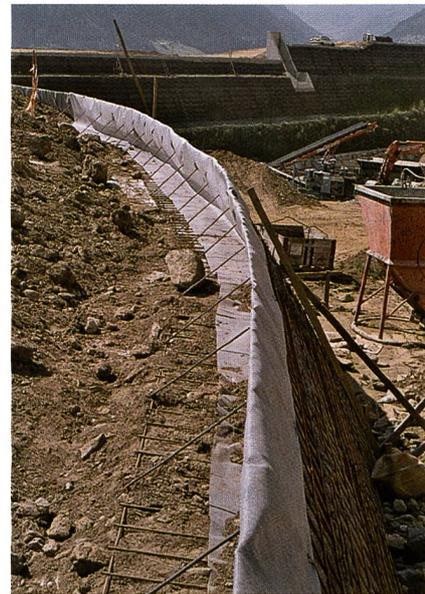
Abb. 3: Bepflanzbares System aus Vliesstoff für Steilböschungen
