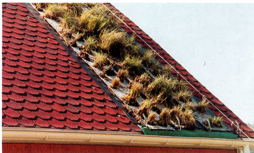
Bild 4: Pflanzenträgermatten zur Steildachbegrünung.
