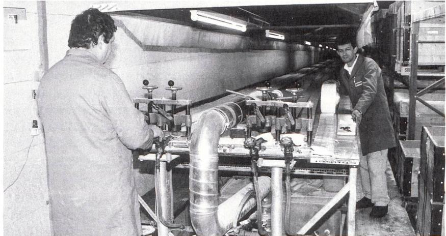
Mittels 6 bar Dampfdruck, welches einer Temperatur von ca. 130 °C entspricht, wird der Gummimanchon mit dem Gewebe verklebt. Die hintere Klemmvorrichtung ist beweglich, weil der Schlauch beim Gummierungsprozess etwa 2% schrumpft. Die Ventile an den hinteren Anschlüssen sind leicht geöffnet, damit das Wasser des Dampfes entweichen kann. Einheizzeit je nach Schlauchlänge und Durchmesser zwischen 10 und 15 min.
