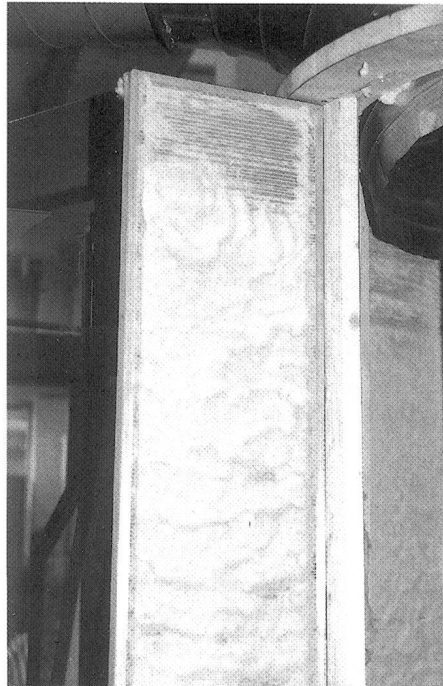
Abb. 4: Mit dem BEN-VAC abgesaugte Staubmenge
