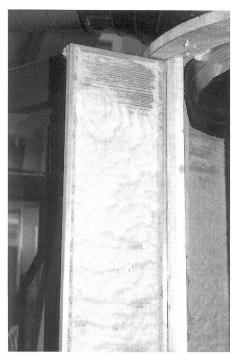
Abb. 4: Mit dem BEN-VAC abgesaugte Staubmenge
